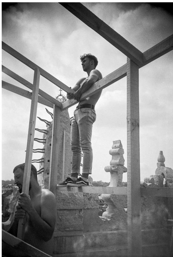
Fot. 2. Klasztor Benedyktynek we Lwowie, prace konserwatorskie, 2024 r.
