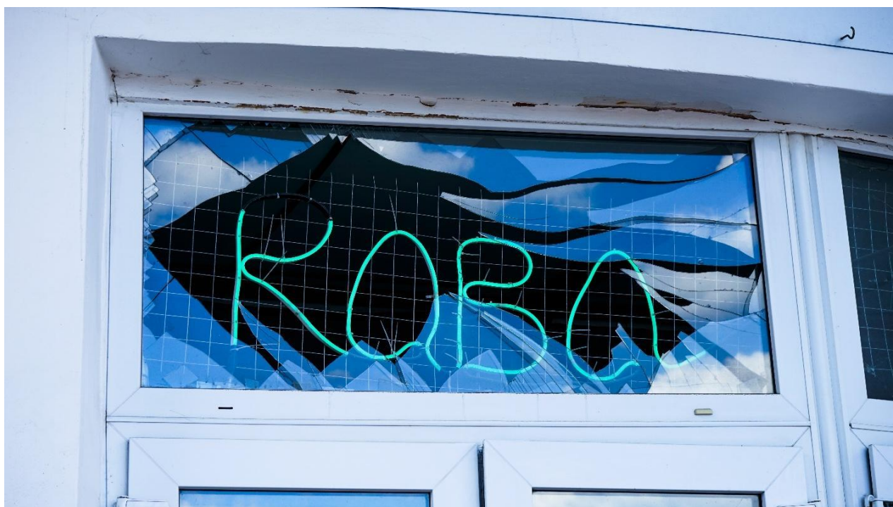
Fot. 7. Czernichów, zniszczona kawiarnia, czerwiec 2022 r.
